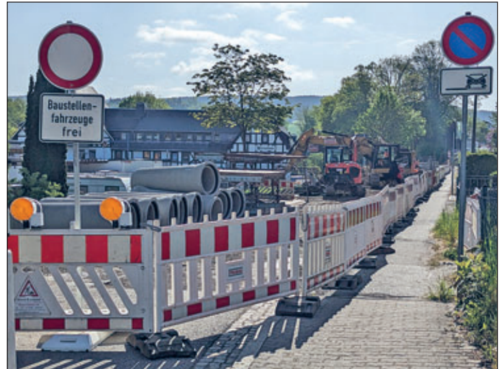
Aktuell laufen die umfangreichen Bauarbeiten auf der Annaberger Straße.
