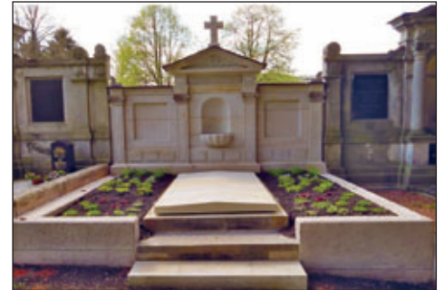
Vollständige Ansicht der neu gestalteten Grabanlage, die künftig als Urnengemeinschaftsanlage (UGA 14) genutzt wird.
