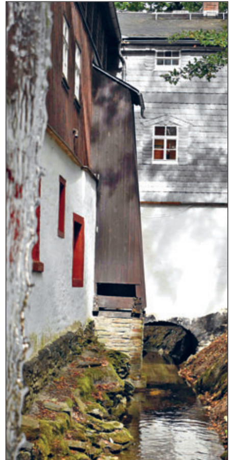
Rückseite der Mühle mit Plumpsklo über dem Mühlgraben
